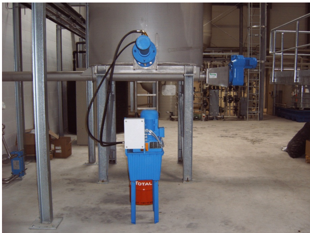
Бункер для шлама с разгрузочным шнеком
