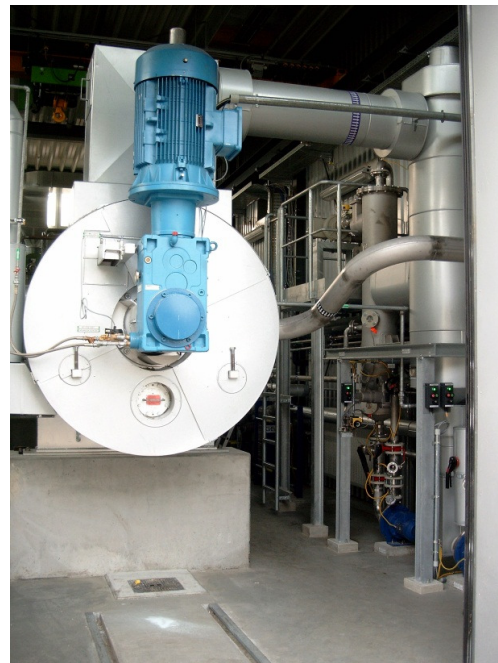
Blick in die Trocknungshalle
