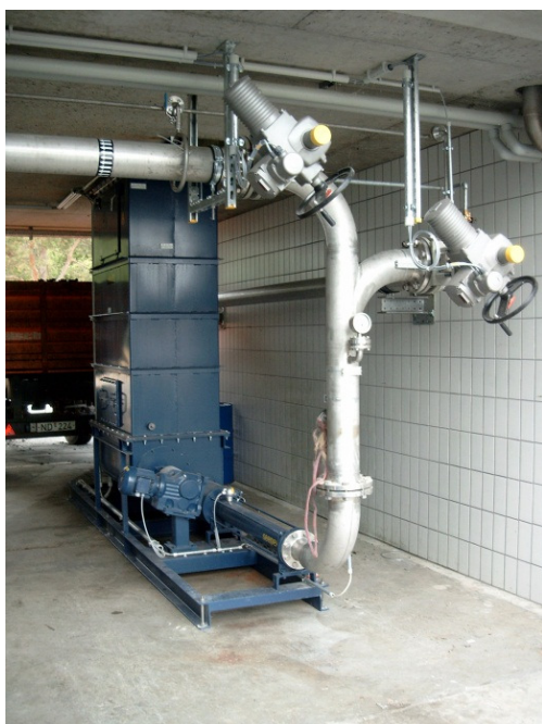
Насос для густой массы с наполнительным бункером и устройством против образования мостиков
