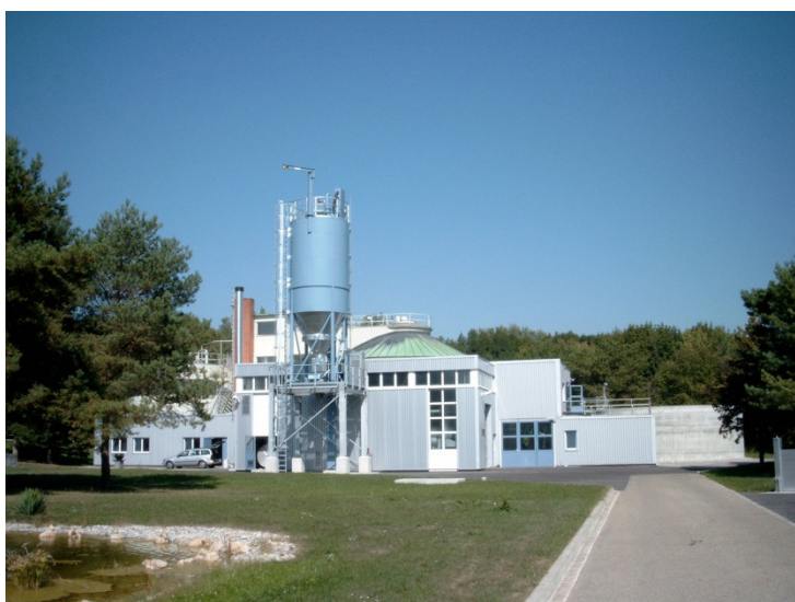
Общий вид установки
